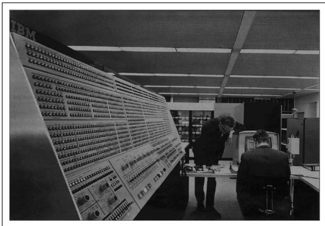
Rysunek 1.1. Wczesny komputer chmurowy: IBM System/360 Model 91 w NASA Goddard Space Flight Center
