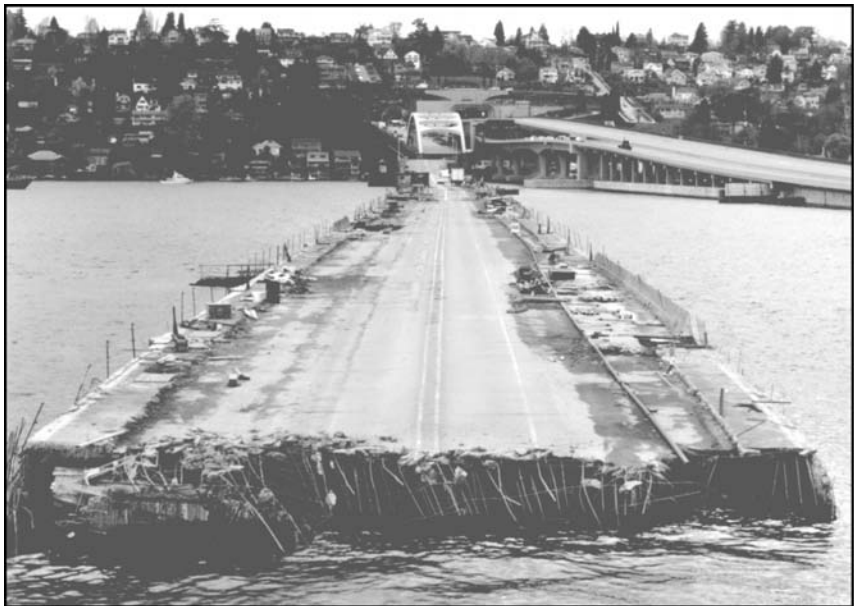
Rysunek 8.1. Część pływającego mostu na drodze I-90 w Seattle zatonała w trakcie burzy, ponieważ nie zamknięto pływaków, które utrzymywały go na powierzchni wody. Deszcz zalał je i most stał się zbyt ciężki. W trakcie budowy oprogramowania zabezpieczanie się przed drobiazgami ma większe znaczenie niż się wydaje.
